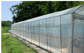
ภาพที่ 4 โครงสร้างโรงเรือนที่ใช้เหล็ก คลุมด้วยพลาสติกกัน UV
